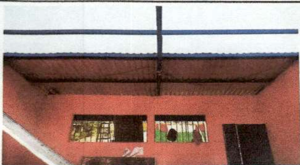
Foto 3: Vista frontal de aulas
