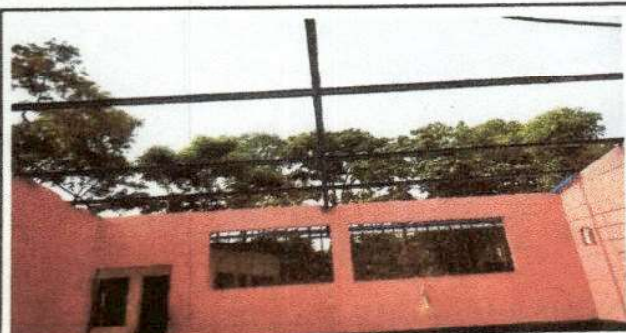
Vista frontal de canales para agua pluvial
