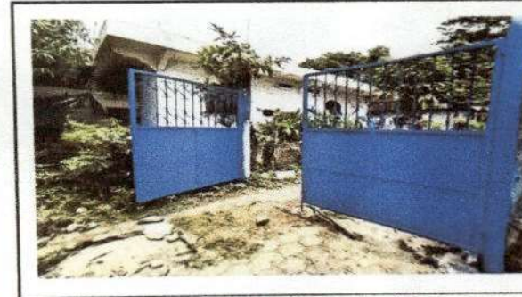
Foto 6: vista de entrada principal del centro educativo
